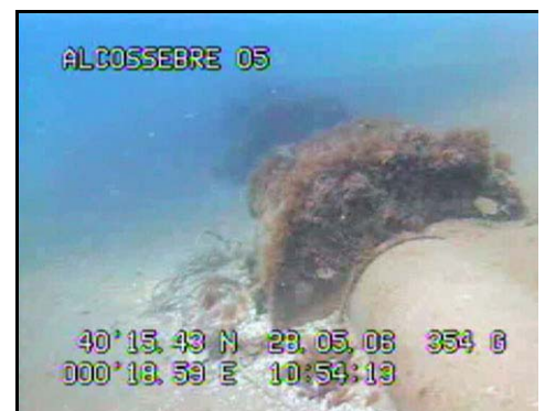
Imagen de un emisario obtenida con la cámara de video remolcado Mariscope
